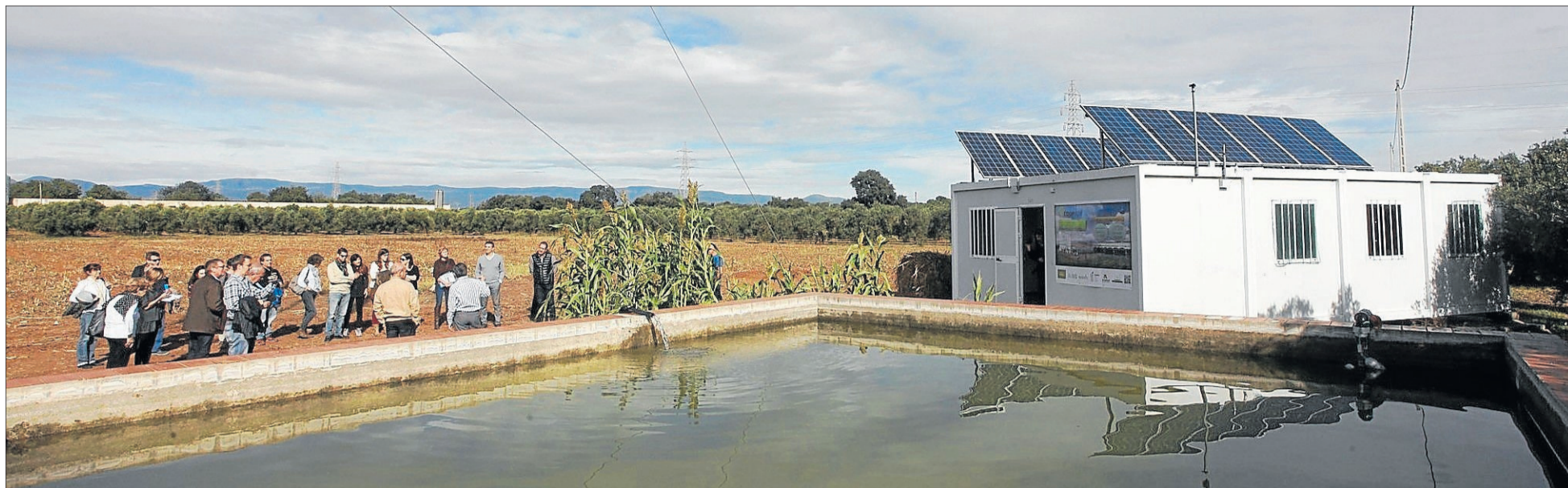
La estación fotovoltaica, junto con el aerogenerador, producen prácticamente la totalidad de la energía que la Cooperativa de Cambrils necesita para el riego. FOTO: ALBA MARINÉ
